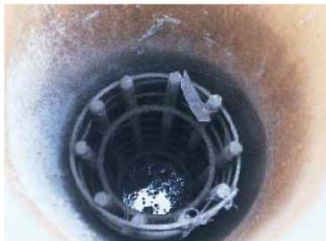
Стальная арматура в обсадной трубе перед закачкой бетона
