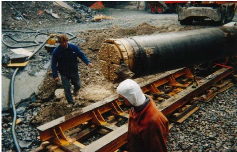
609-миллиметровая буровая коронка и обсадная труба на выходе после горизонтального бурения протяженностью 44м (частично в граните) (Швеция)
