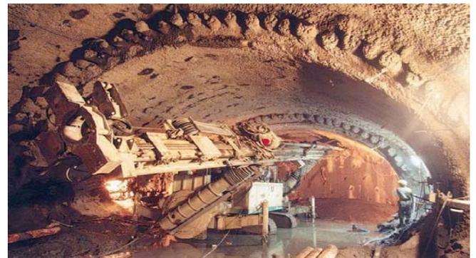
Тоннельная крупногабаритная установка начинает разработку устья с помощью Symmetrix T (сверху слева) и Установка для проходки выработки в тоннеле (сверху справа)
