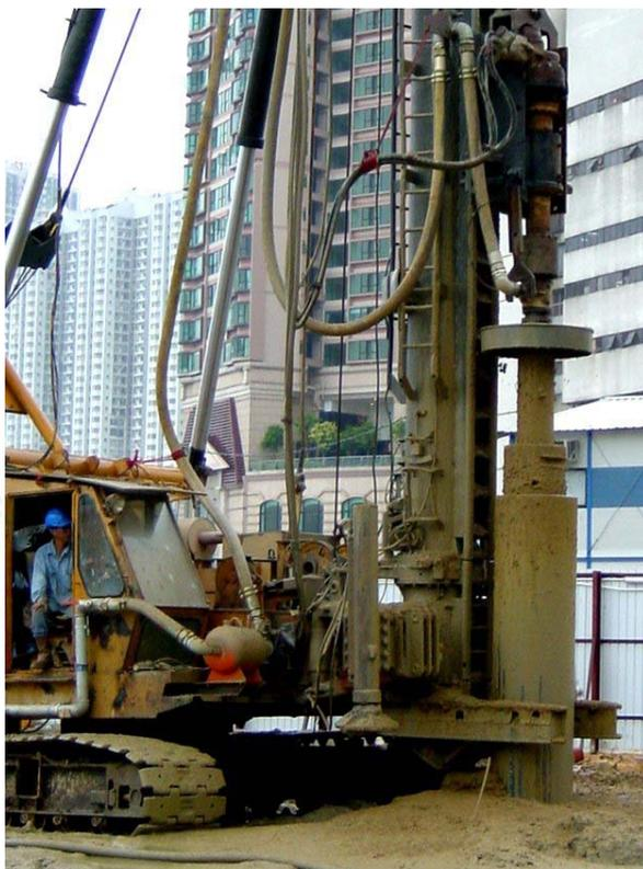
Для этих целей используются ведущие машины, например, копер с модифицированной роторной головкой для погружных работ или буровая установка, оснащенная переходником буровой трубы. Следует установить пневмолинию с управлением из кабины с автоматической маслёнкой для погружного пневмоударника.
